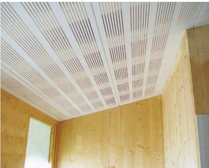
◀ Für eine gute Akustik sorgen Fräsungen in der fertig lasierten Oberfläche der Deckenelemente
